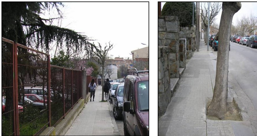
Fotografia 3.1.13 – Voreres no accessibles al c/ Palau de Plegamans
