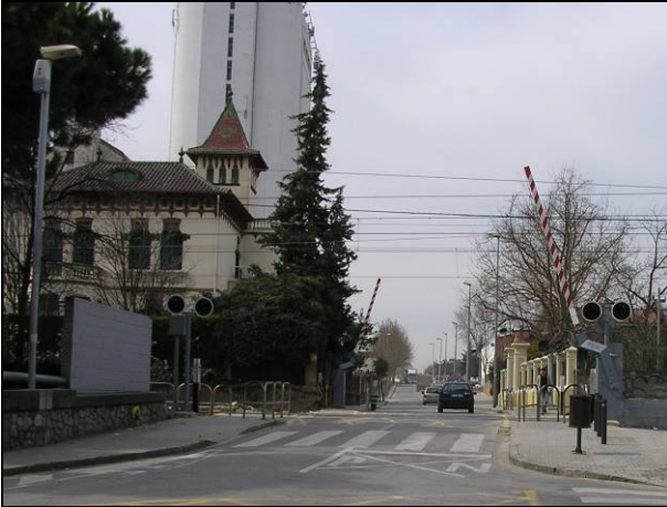
Fotografia 3.1.19 – Pas a nivell a l'av. Rafael Casanova
