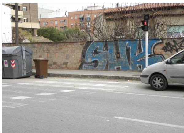
Fotografia 3.1.12 – Pas de vianants no adaptats a av. Burgos
